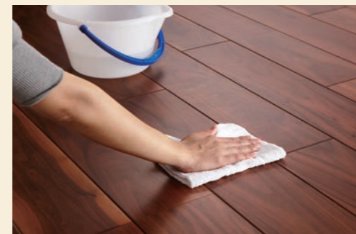
③きれいに水洗いした雑巾等で水拭きを2回以上くり返し、完全にクリーナー成分を拭き取ります。 ※クリーナー成分が残っている場合は、床が変色する又は艶が変わる場合があります。
