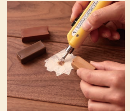
補修用パテを暖めて傷部分に埋める。
